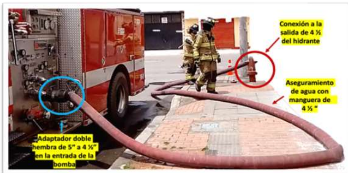
Figura 2. Abastecimiento con hidrante y manguera de gran caudal. 15
