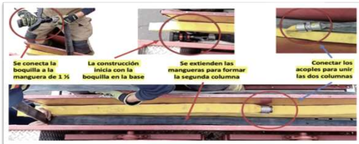
Figura 21. Construcción de la segunda columna. 38
