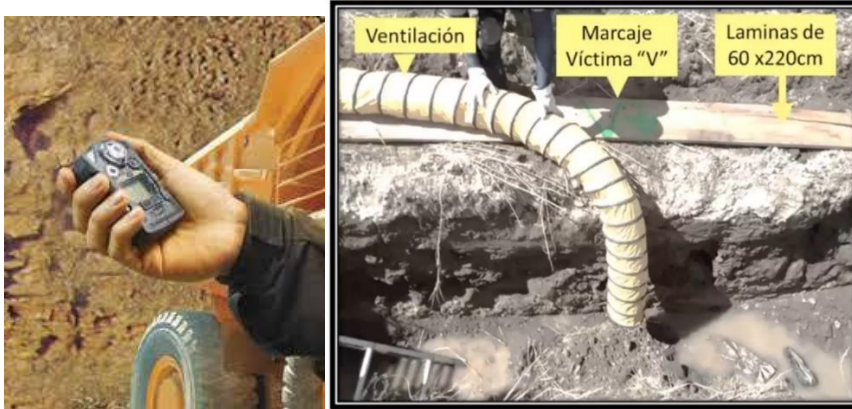
Ilustración 221 MONITOREO DE ZANJA
