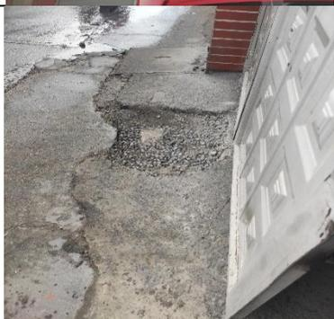
Se observó hueco en el piso a la salida del cuarto de máquinas, generando riesgo.
