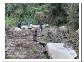
obstrucción y taponamiento de la vía por sedimentos y rocas removidos como un flujo de detritos desde el cauce de un drenaje secundario.
