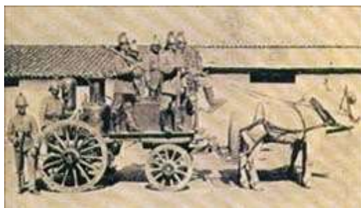
Figura 2. Bomba de vapor
